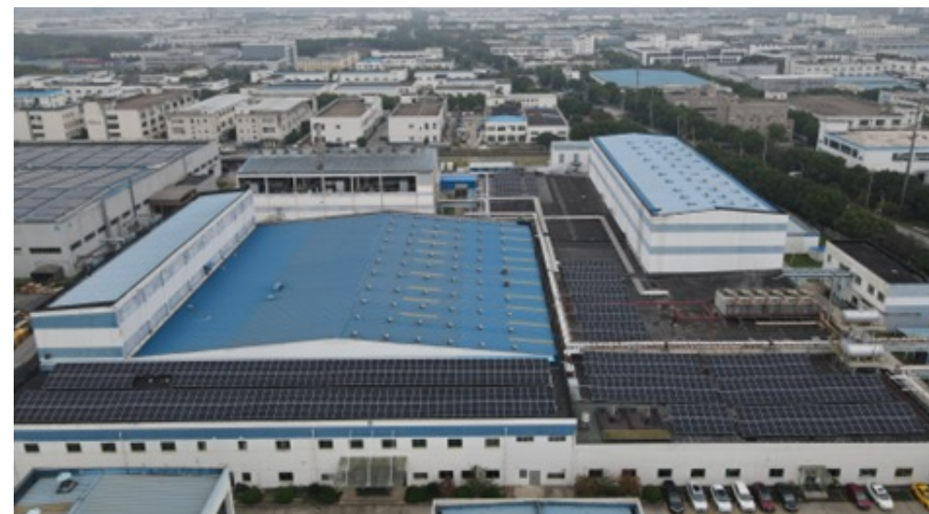
▲ 騰輝電子蘇州廠 太陽能發電板
